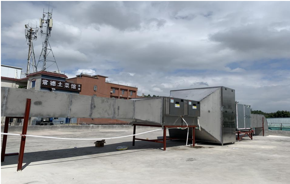
从左至右依次为高频多点放电气体分解装置、 空气还原装置和风机
