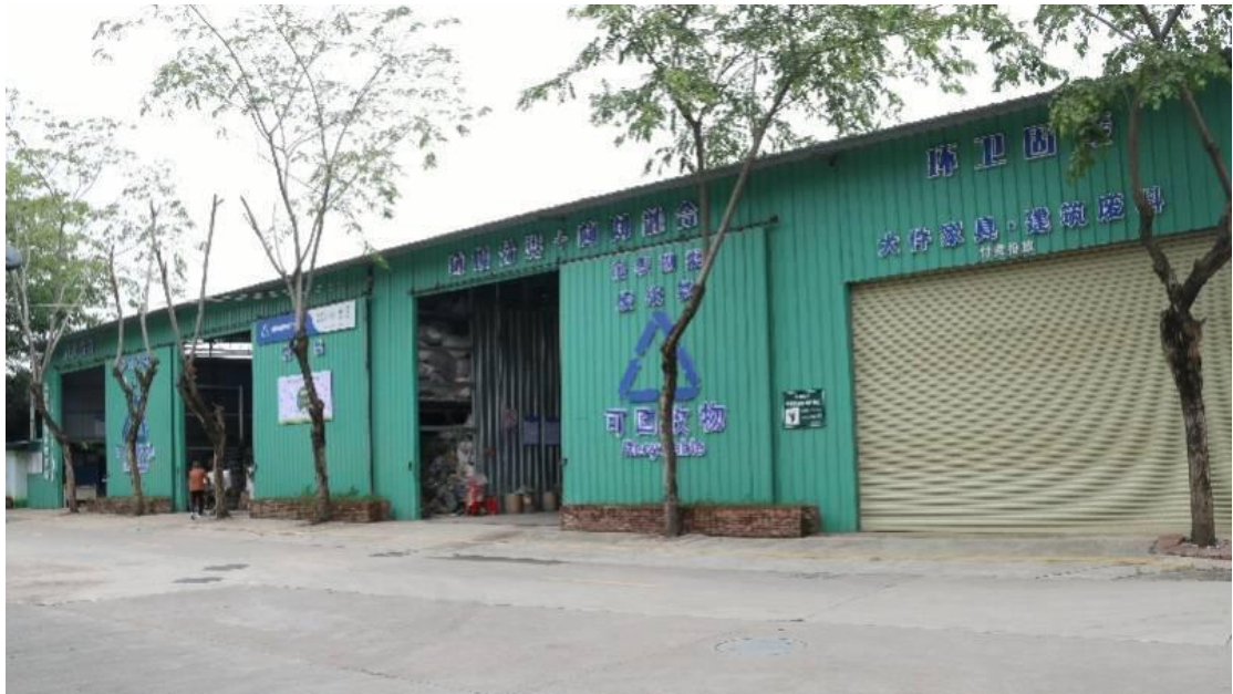
南城石鼓社区垃圾分类“两网融合”固废转运站
