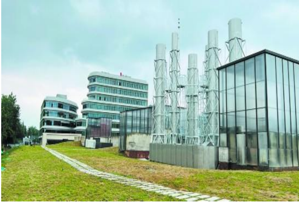
全国首座 2000 吨全地埋垃圾压缩转运中心(地上建筑)
