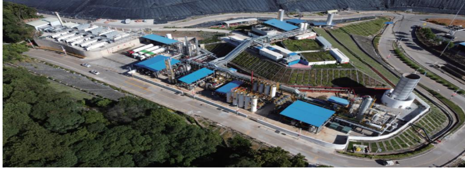
图 1 广州兴丰生活垃圾卫生填埋场填埋气制 LNG 项目现场
