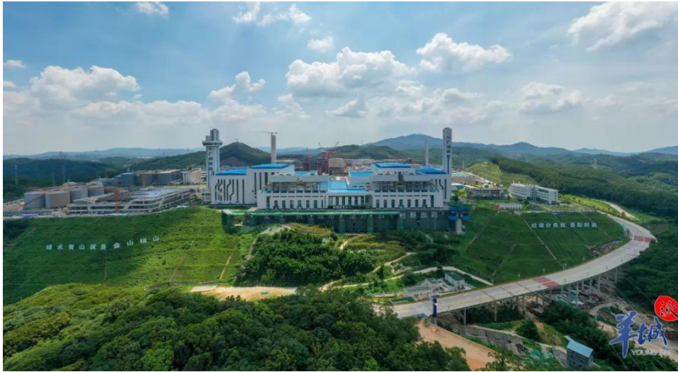
广州市福山循环经济产业园
