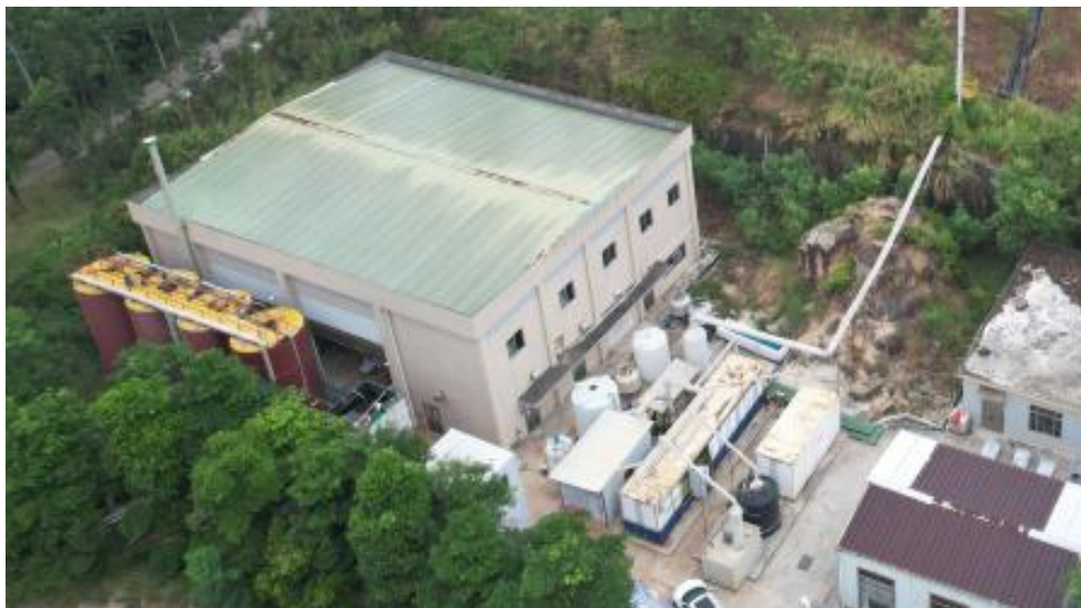
图 5 樟洋生活垃圾填埋场渗滤液应急处置项目现场情况图 (来源：广州金龙峰环保设施有限公司供稿)
