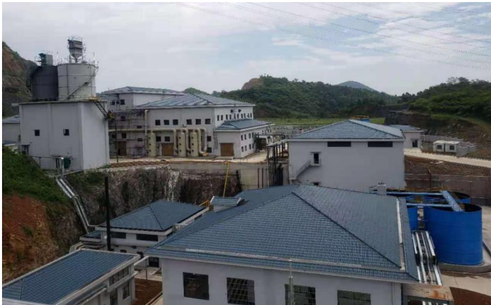
湖州 5 万吨/年示范工程项目图
