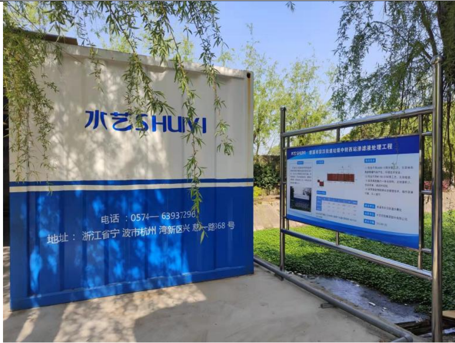
图 2 宗汉垃圾中转西站渗滤液处理项目现场
