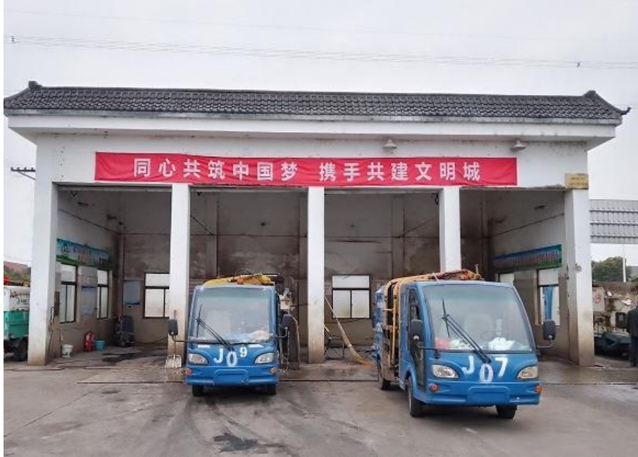
图3 高邮垃圾中转站渗滤液处理工程现场
