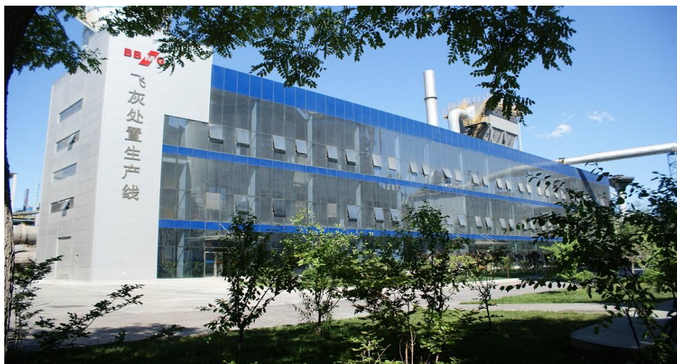
北京市琉璃河水泥有限公司飞灰水处理工程
