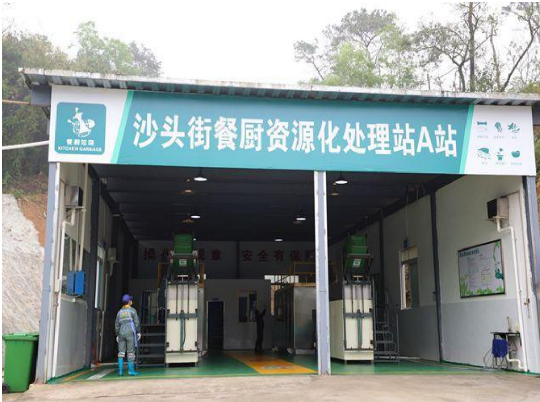
沙头街餐厨垃圾资源化处理站
